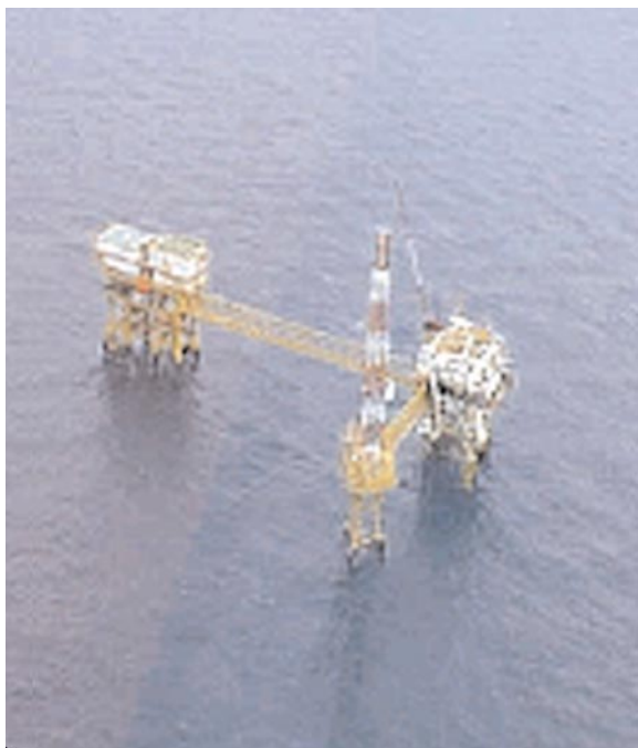
Cayo Arcas Platform
